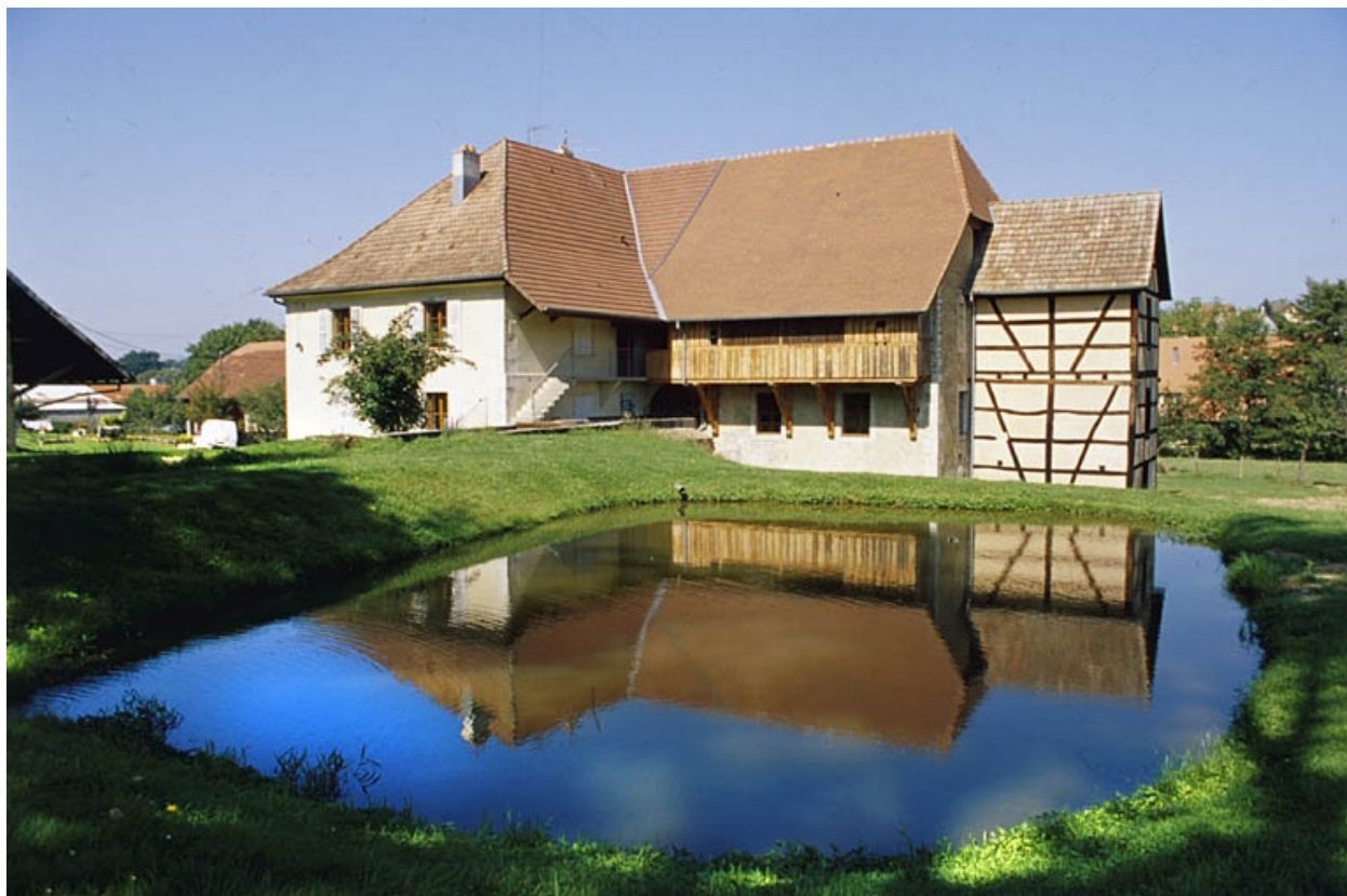
Façades postérieures du moulin.
