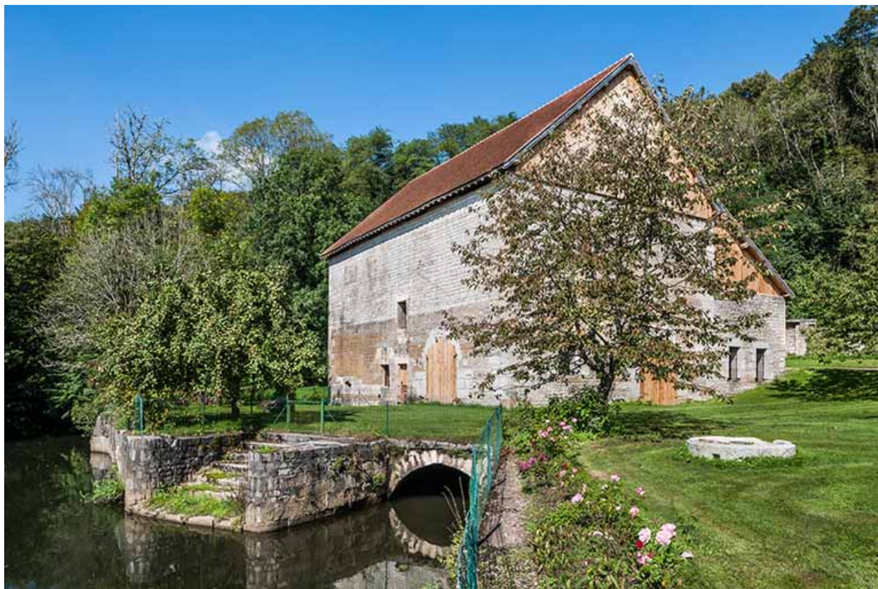
Bâtiment du haut fourneau depuis le sud-est.
