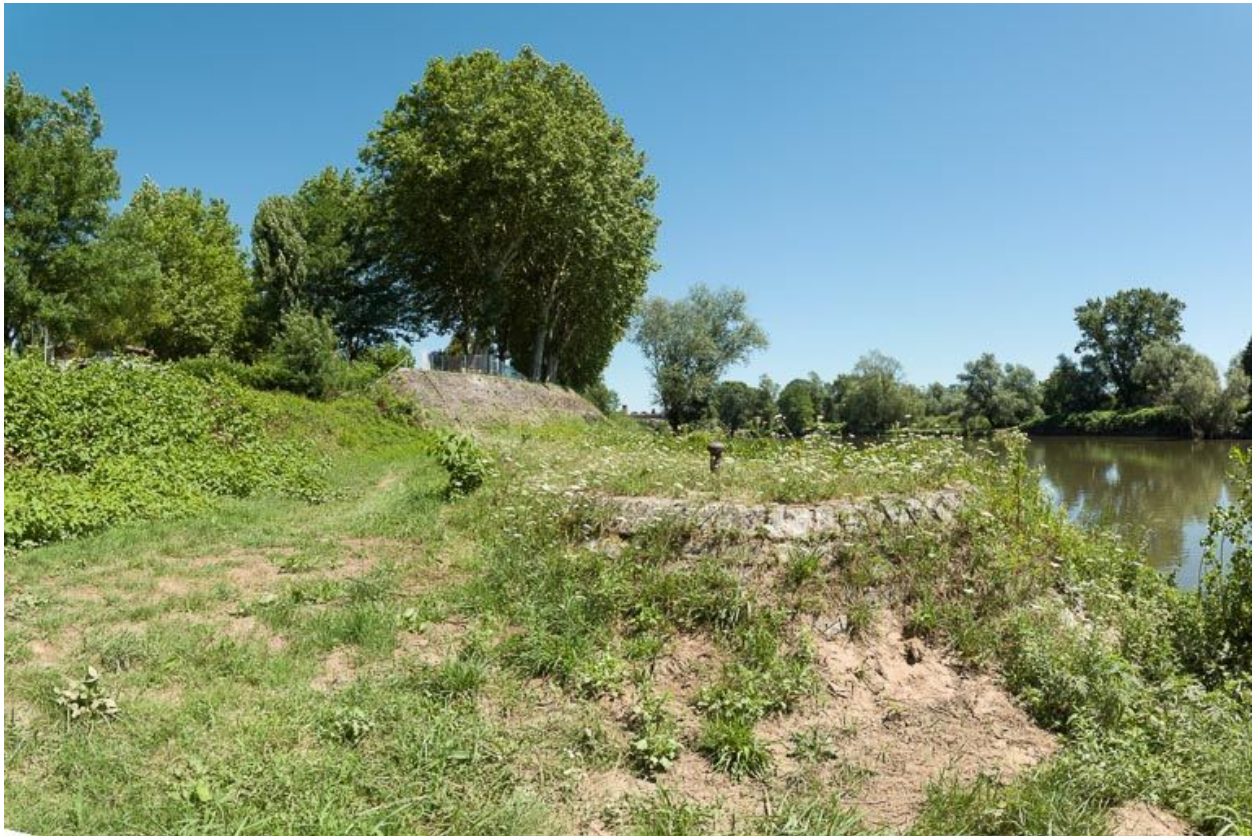
L'ancien bajoyer et la Loire.
