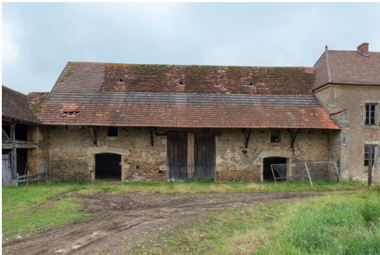
Façade antérieure de la grange
