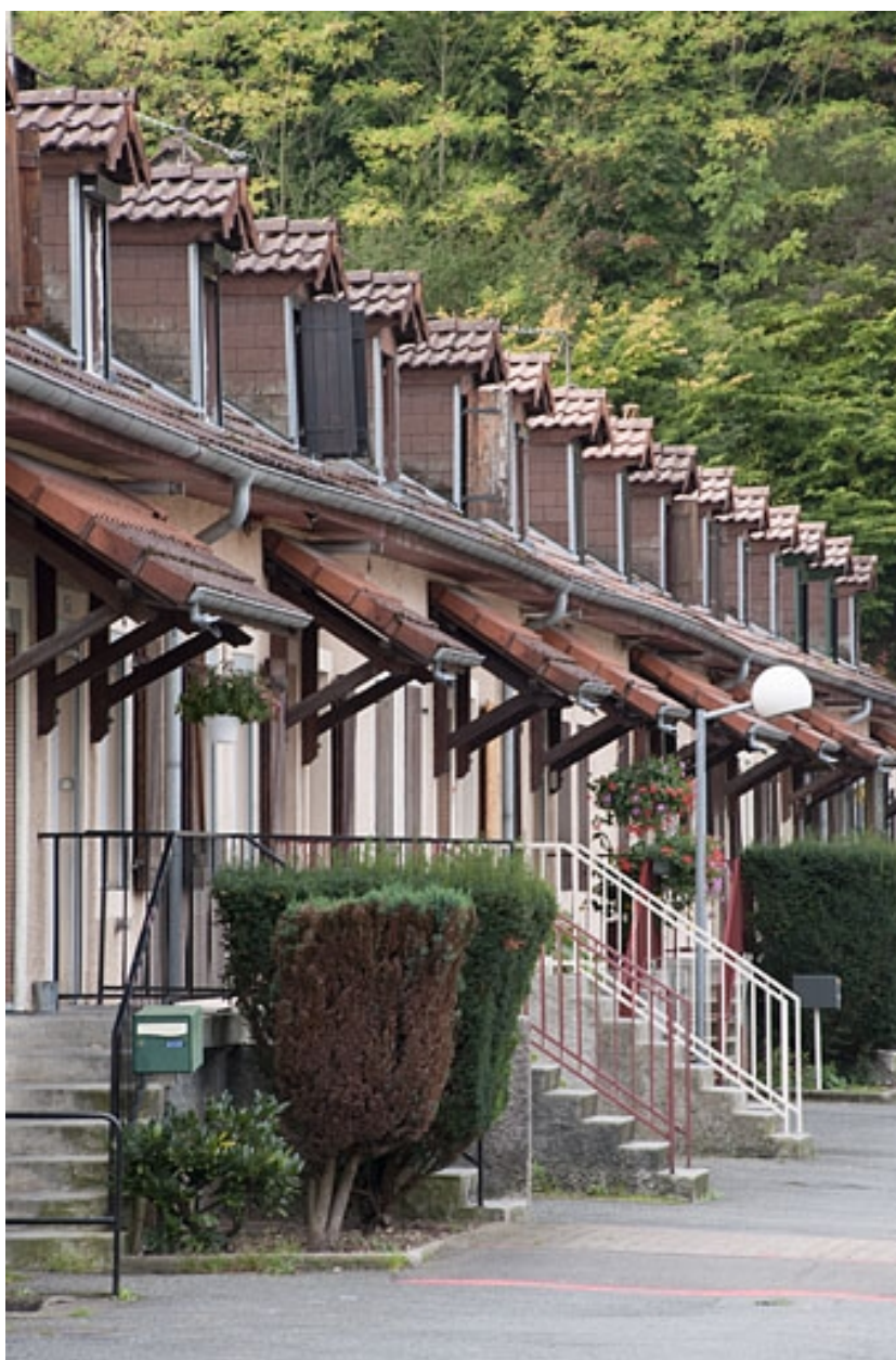
Caserne G. Vue rapprochée depuis l'est.
