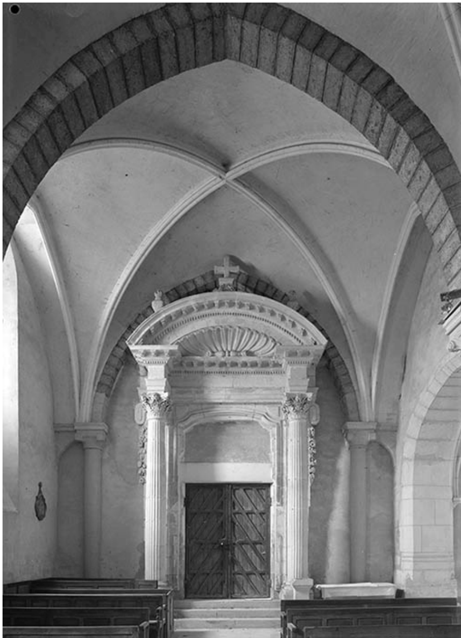
Travée d'un bas-côté avec porte monumentale.
