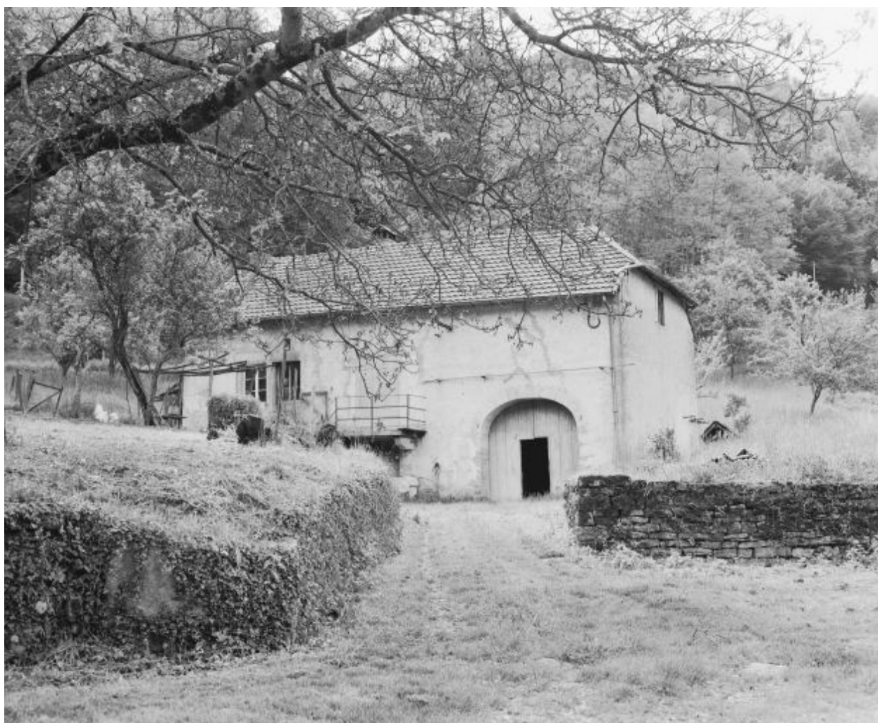
Façade antérieure, vue de trois quarts.
