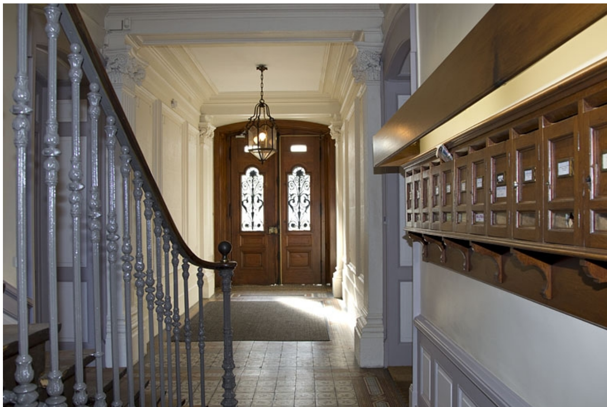
Intérieur : vue du vestibule depuis l'escalier.
