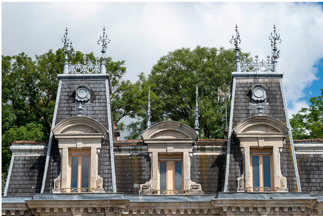
Toiture, côté sud.
