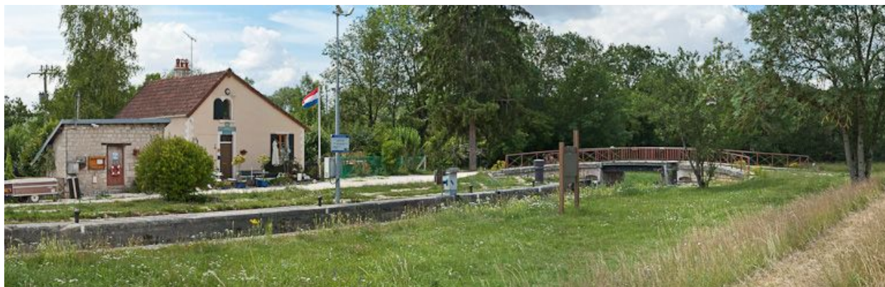
Vue d'ensemble du site d'écluse.
