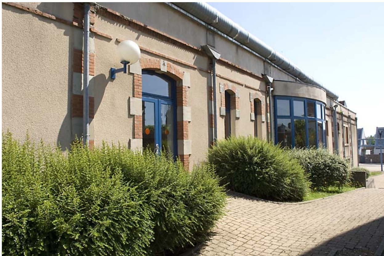
Façade sud de l'atelier de fabrication.
