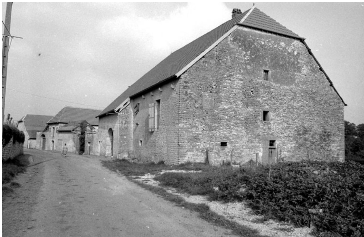
Façade antérieure et latérale droite.
