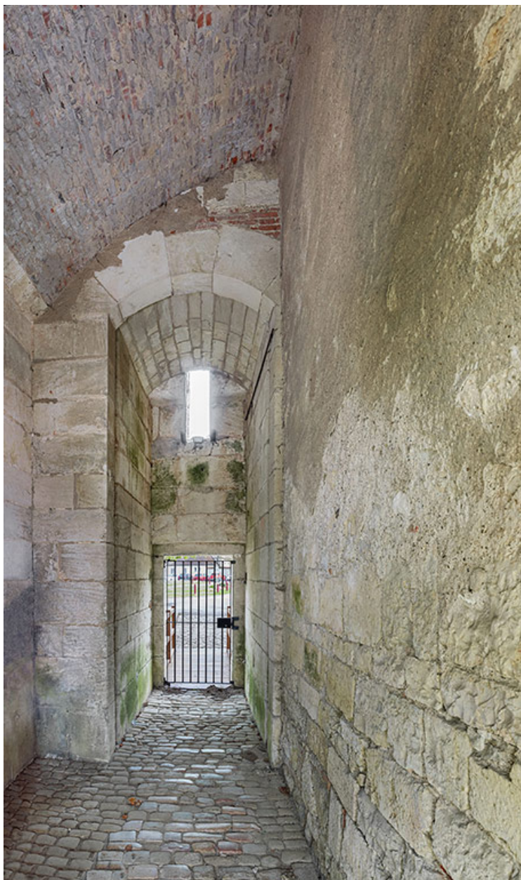
Pavillon d'entrée : passage piéton.
