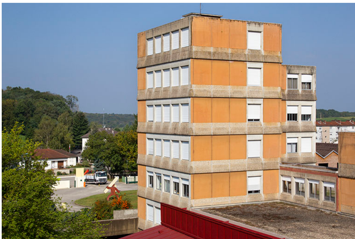
Administration et logements : façades sud et est.
