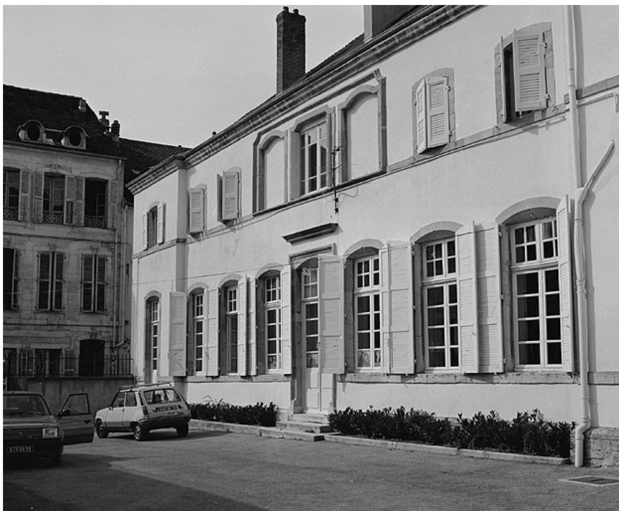
Façade postérieure, détail.
