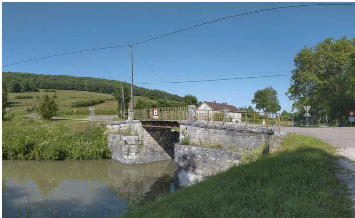
Pont vu d'aval.
