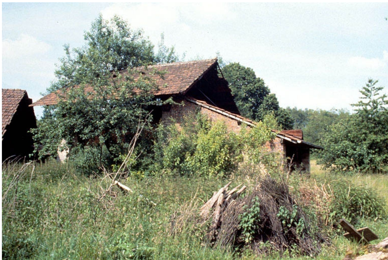
Bâtiment du four (C), depuis le sud.
