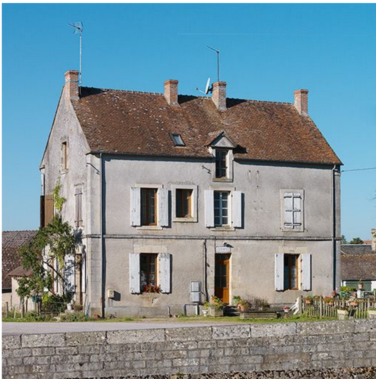
La maison éclusière de face.
