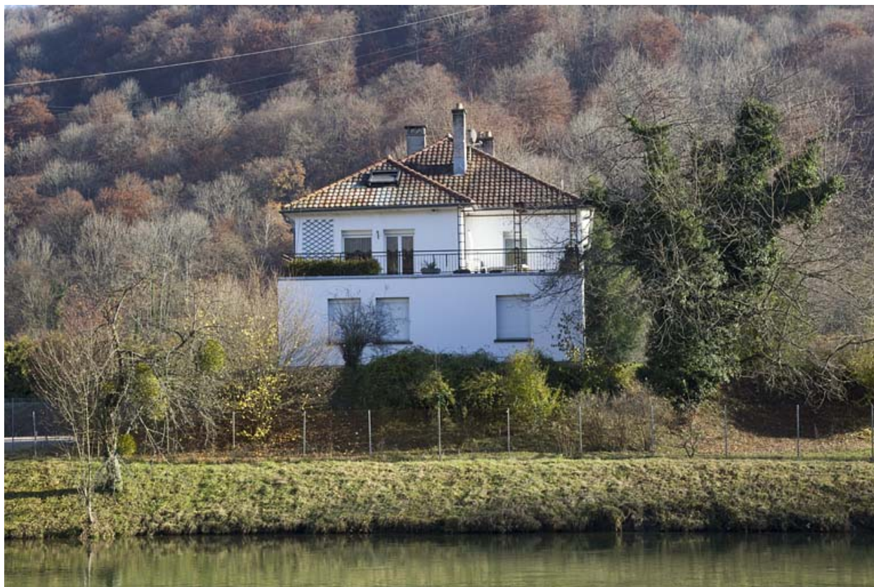
Le logement depuis l'ouest.
