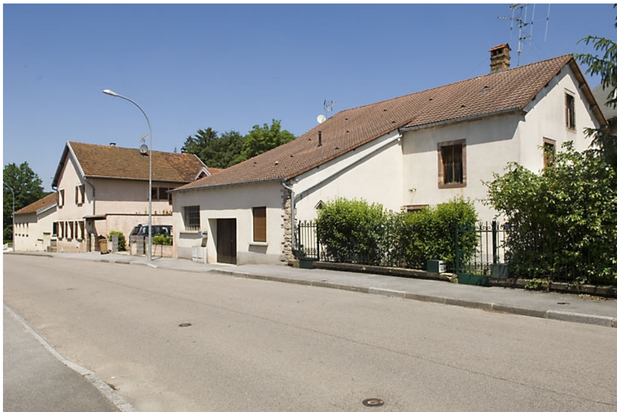
Vue d'ensemble depuis le sud.
