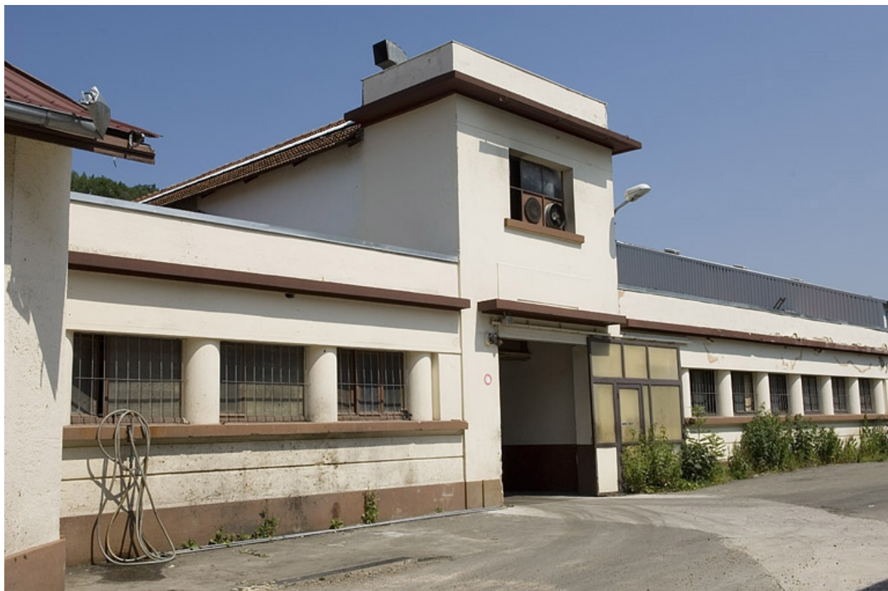
Façade antérieure de l'atelier de fabrication.
