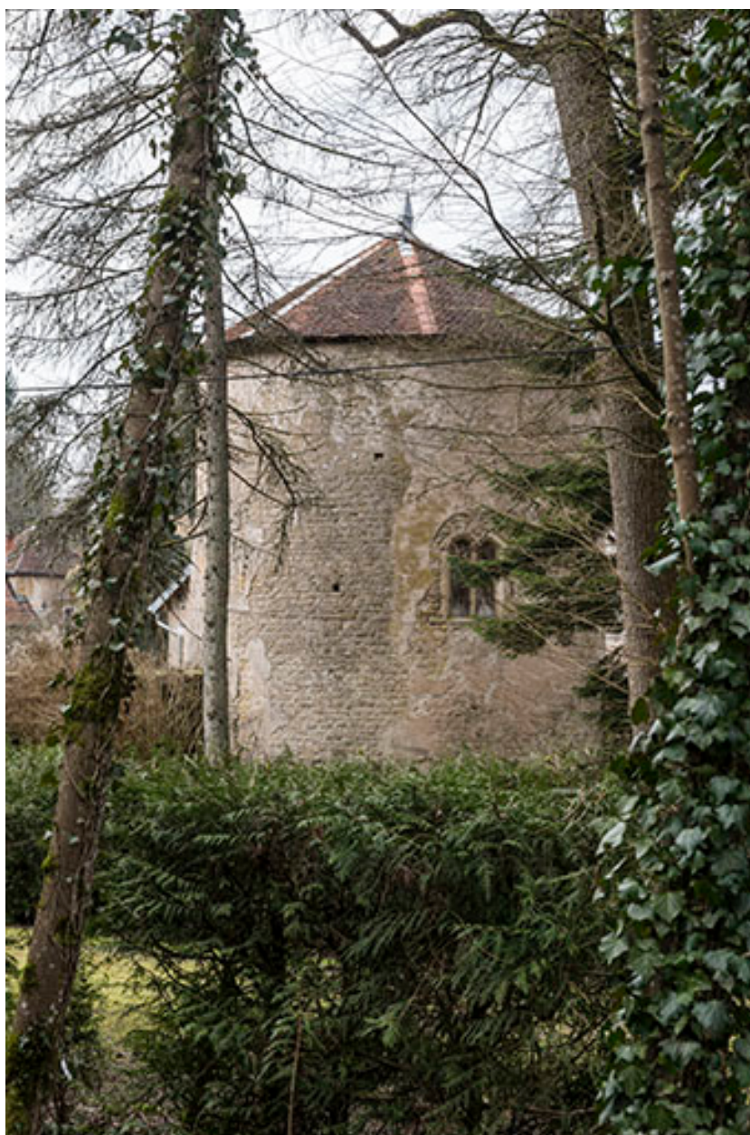
Tour située dans la cour du château.
