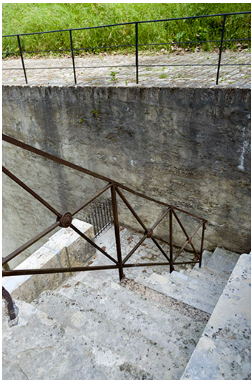
L'escalier et le garde-corps.
