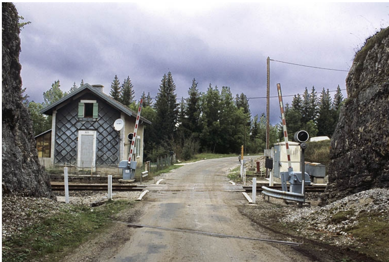
Façade sud (côté voie).
