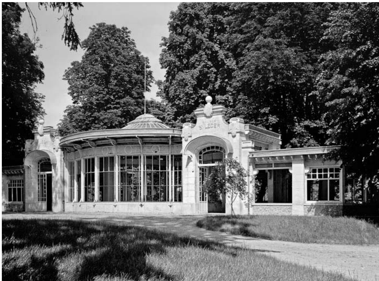
Façade ouest, vue en 1984.
