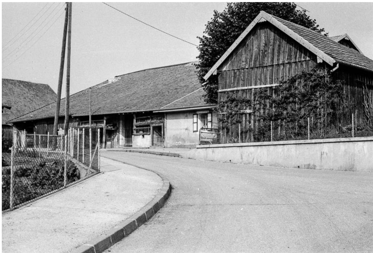
Ferme : vue d'ensemble depuis la rue.
