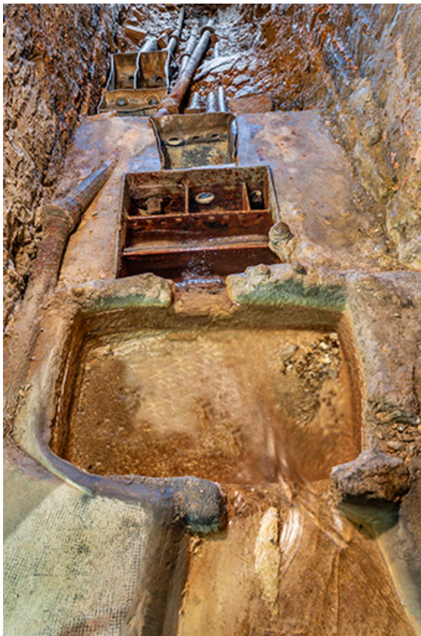
Bassins de division. Vue depuis l'amont.
