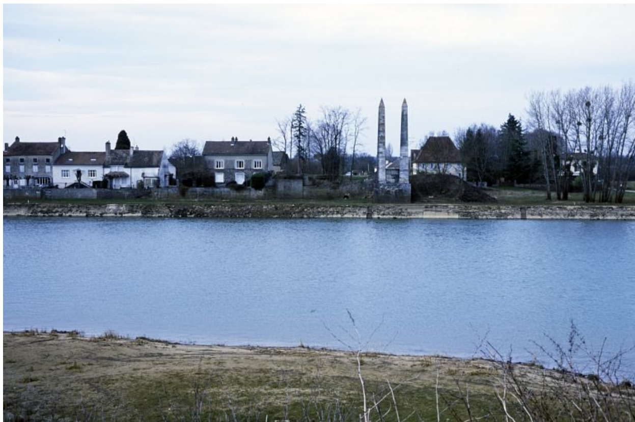
Pylônes, vestiges du pont suspendu en 2003.
