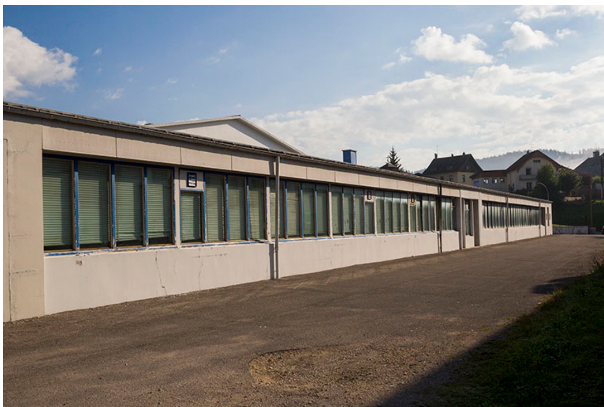
Bâtiment en rez-de-chaussée : façade méridionale.
