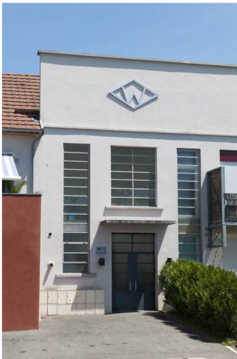
Détail de la façade occidentale.
