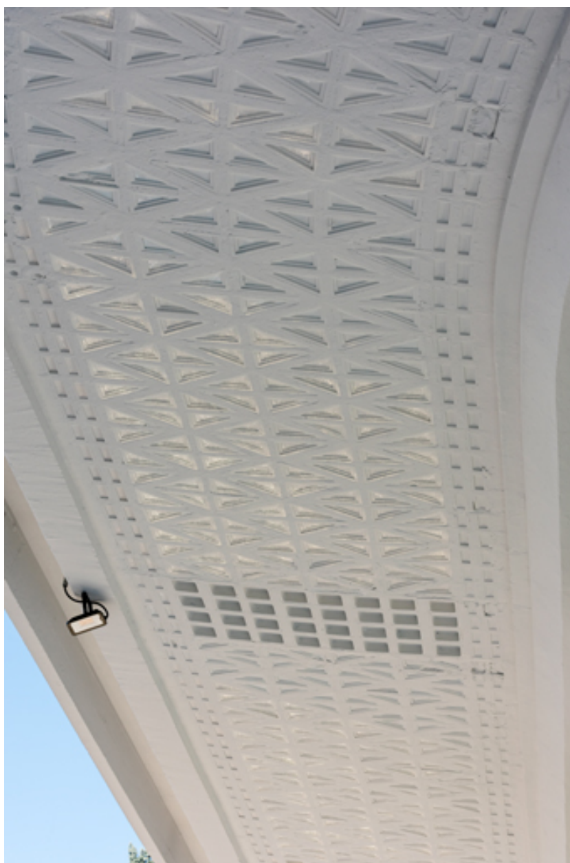
Face inférieure de l'auvent en béton armé.
