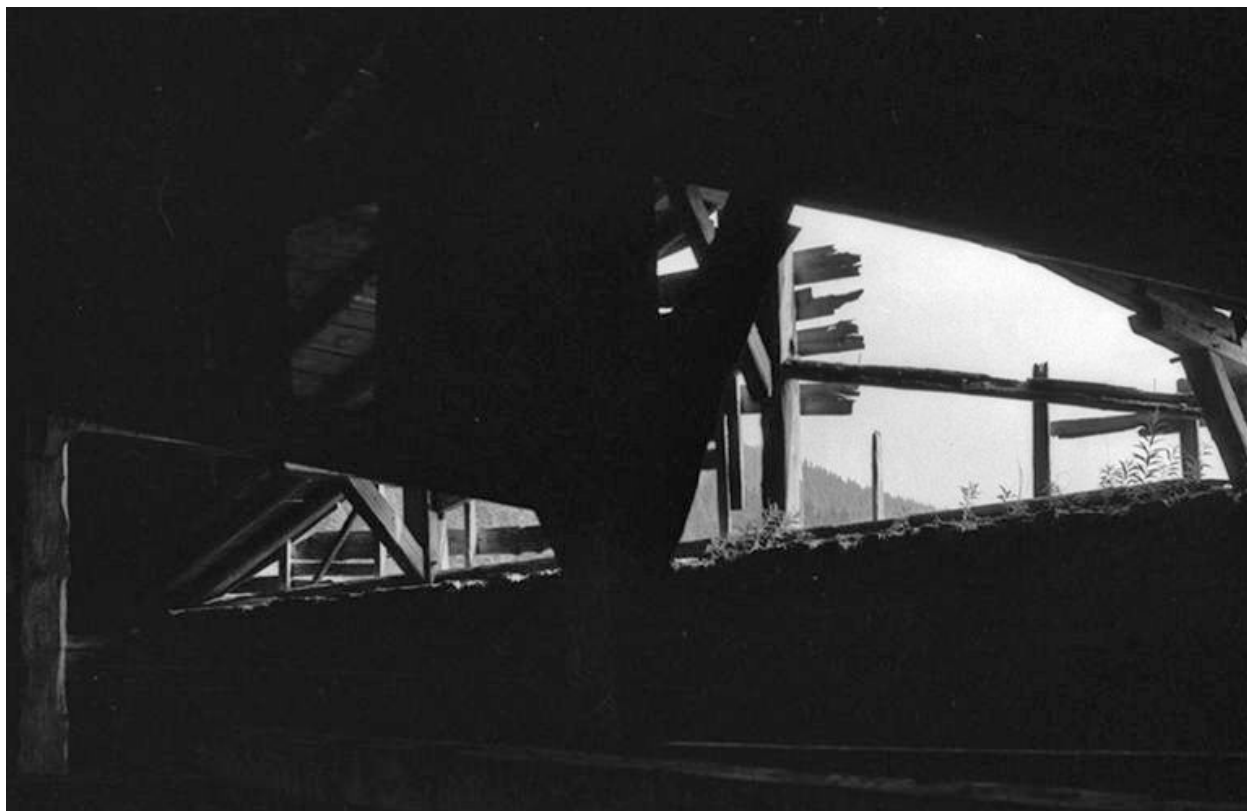
Charpente et "tué".
