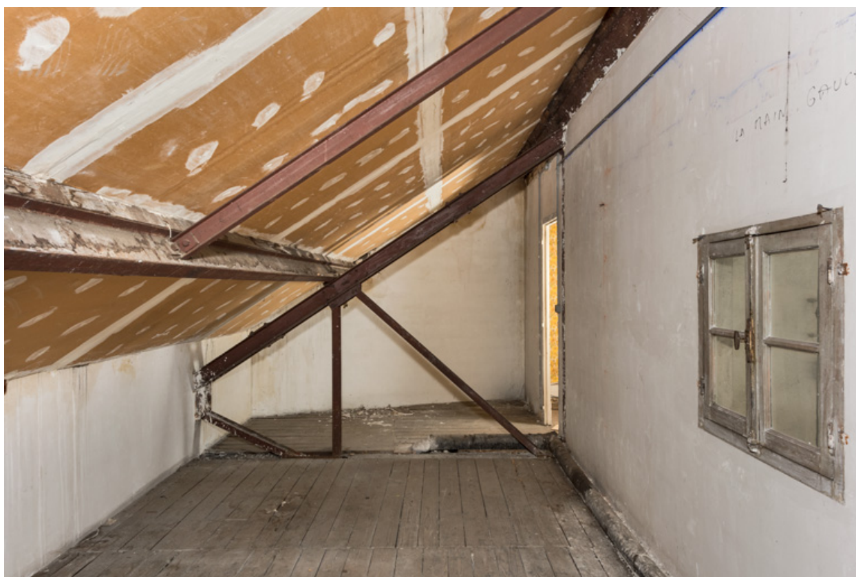
2e étage : charpente métallique.
