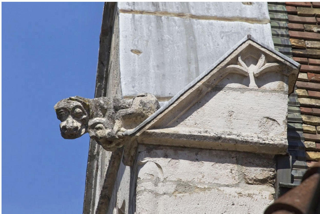
Façade antérieure, lucarne : détail d'une gargouille.
