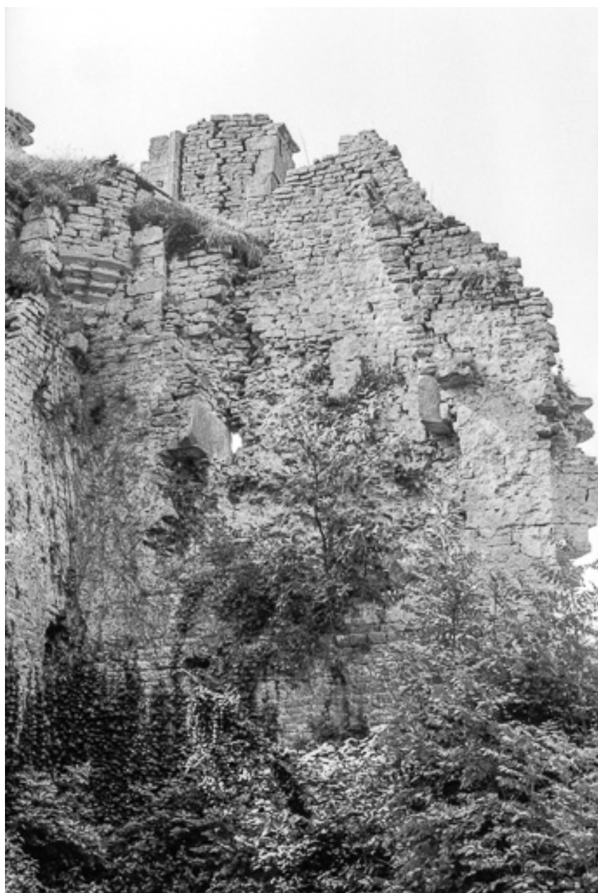
Vue extérieure du donjon.
