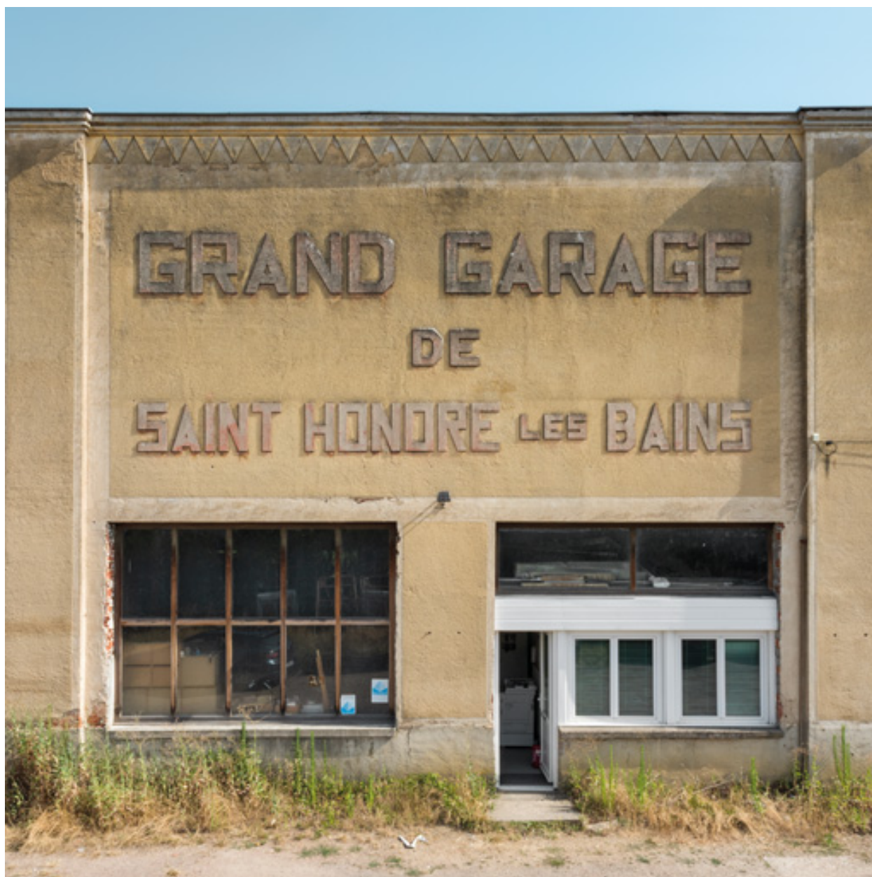
Travée centrale de la façade.
