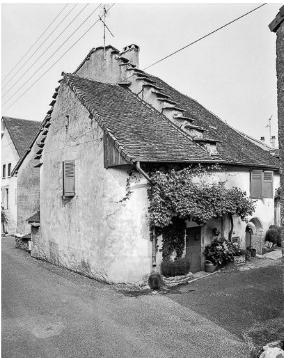
Façades antérieure et latérale gauche.
