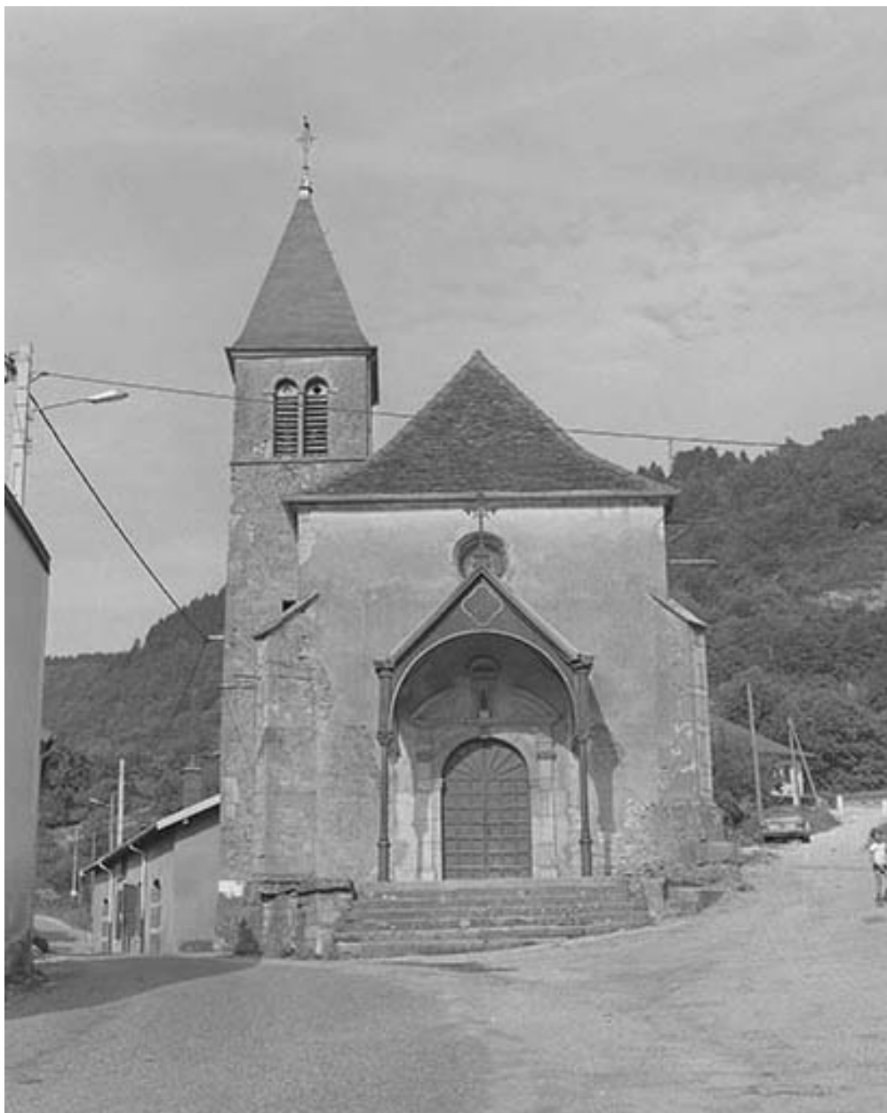
Extérieur : façade antérieure.
