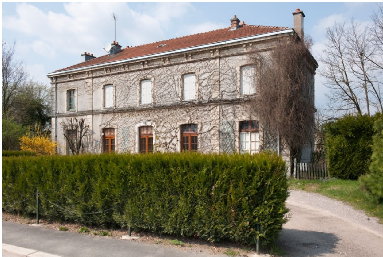
Bâtiment des voyageurs.
