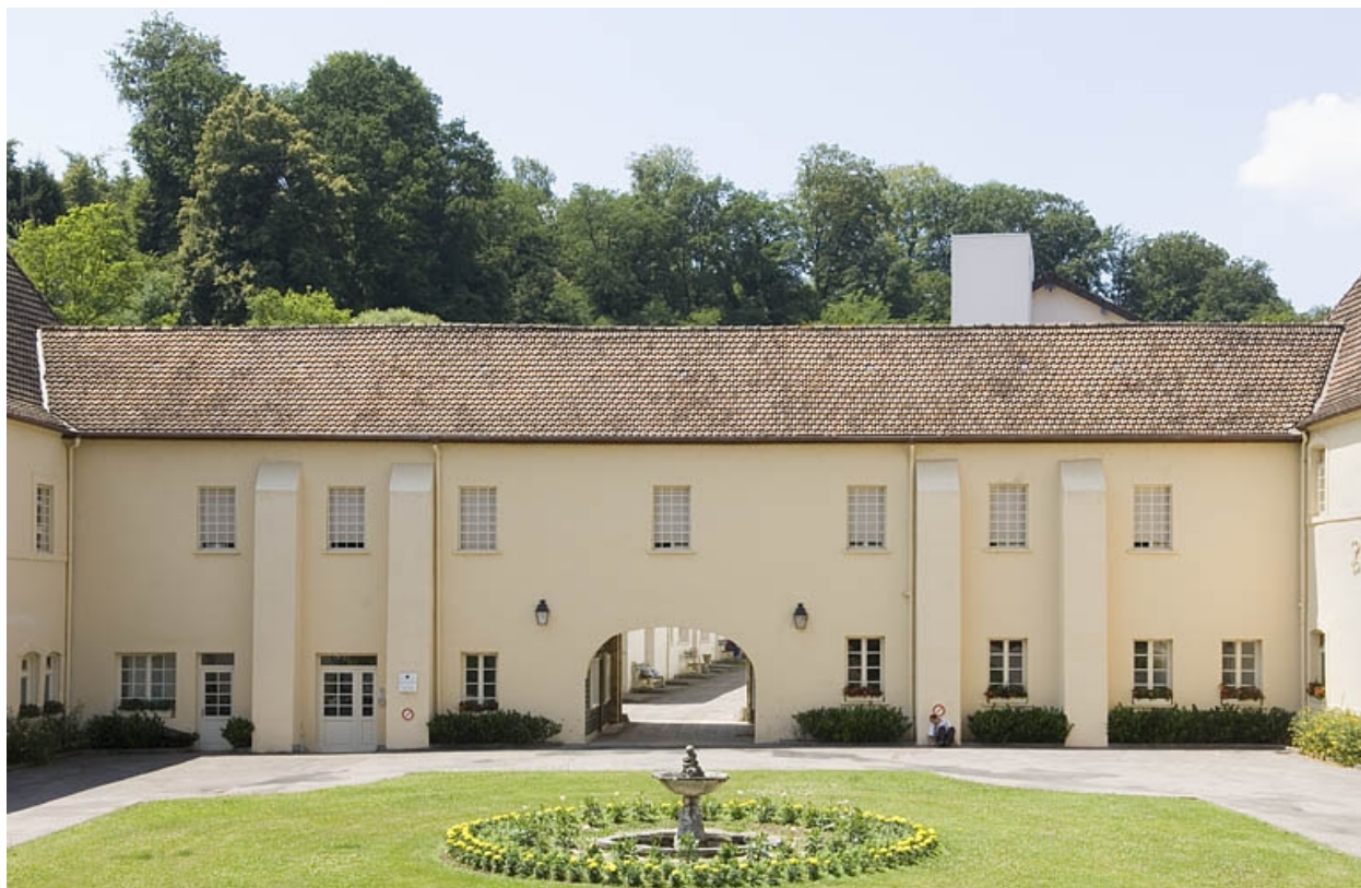
Aile ouest sur cour.
