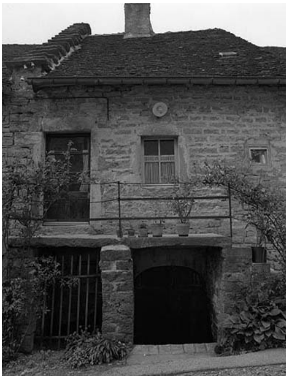
Façade antérieure : habitation.
