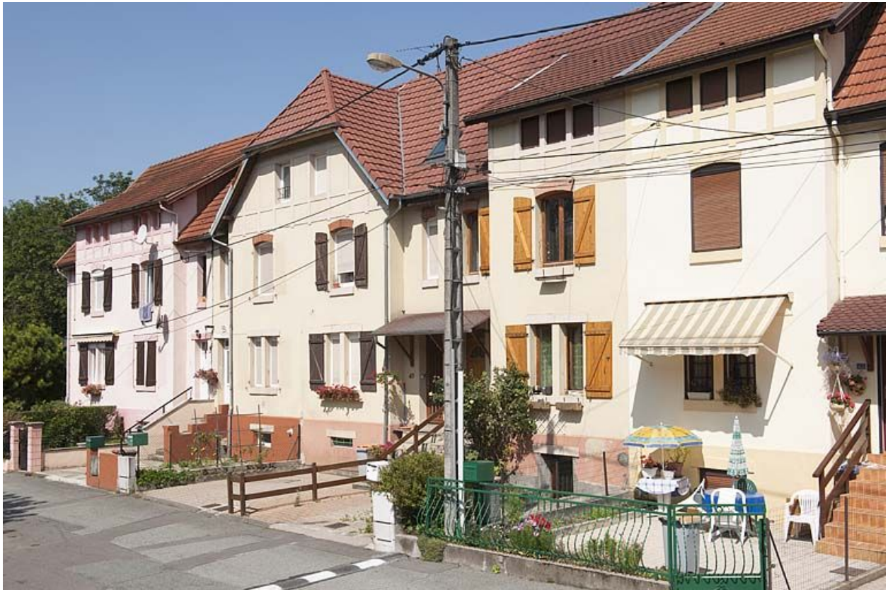
Rue de Somme. Extrémité occidentale de l'immeuble.
