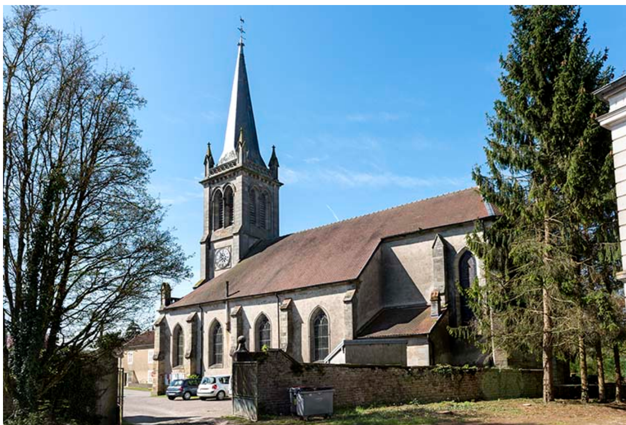
Vue d'ensemble depuis le parc du château.
