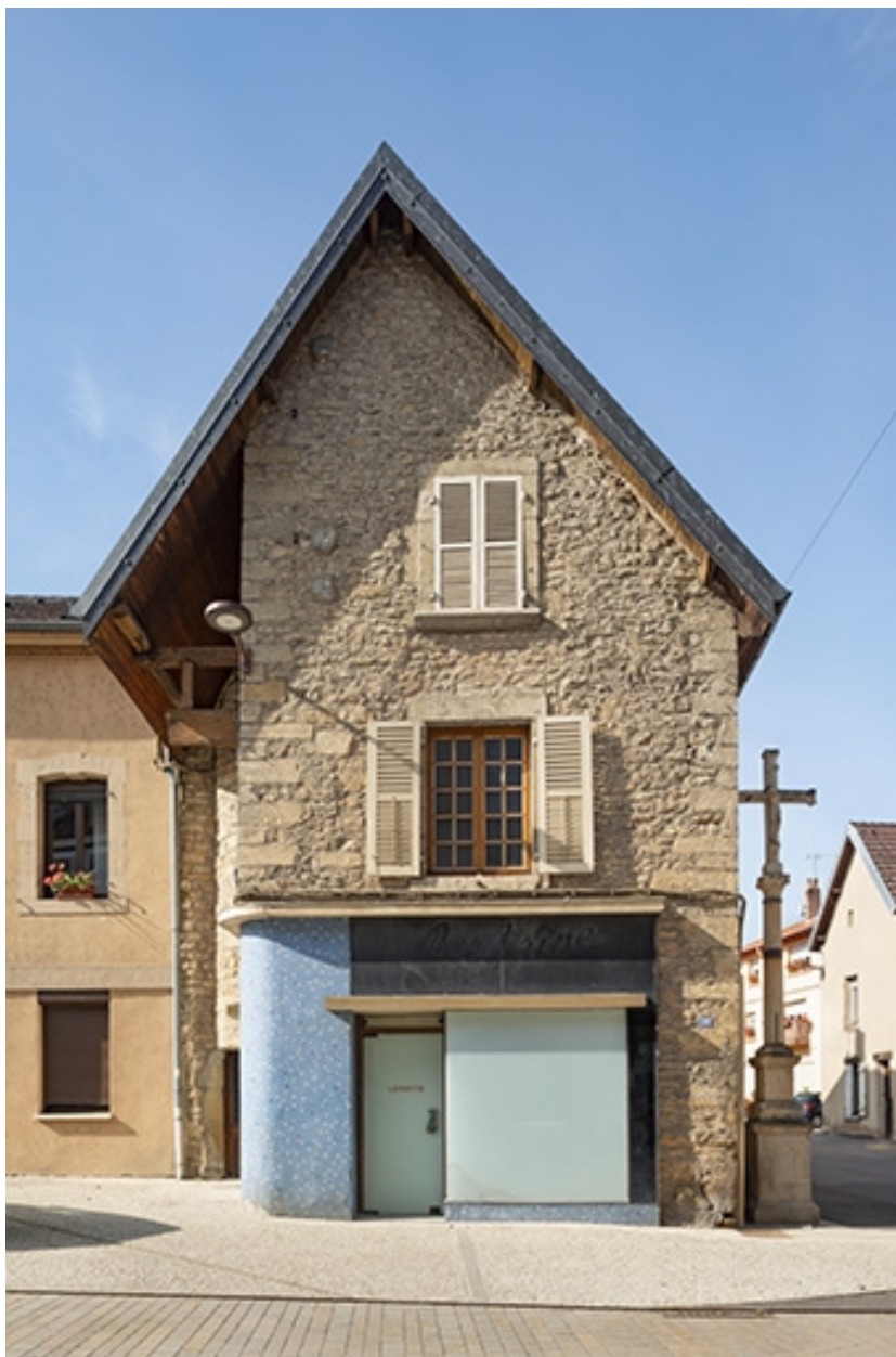
Le pignon depuis la rue Gambetta.
