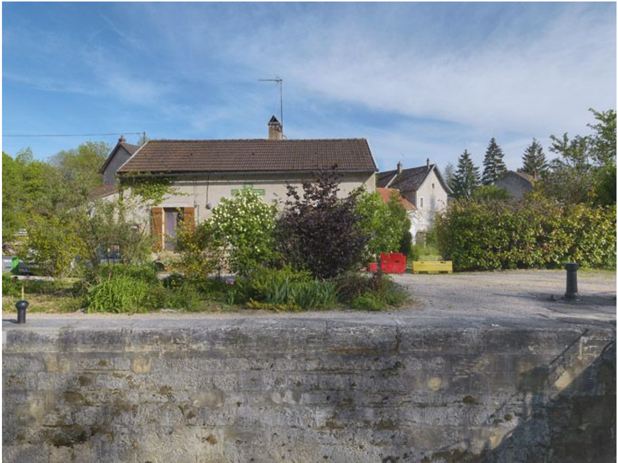
Maison éclésièr de face.
