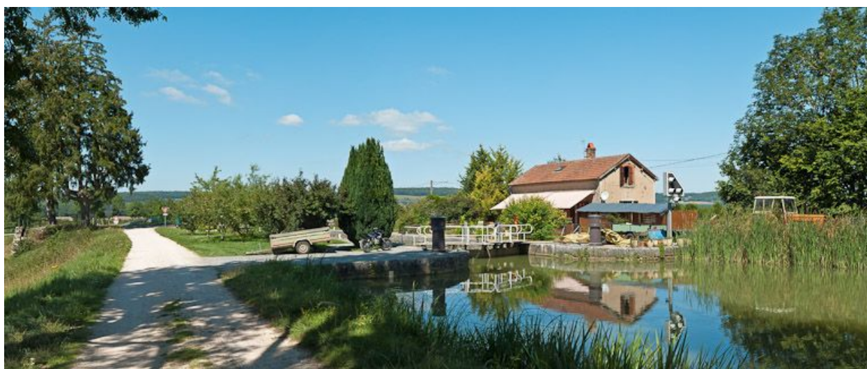
Vue d'ensemble du site d'écluse.
