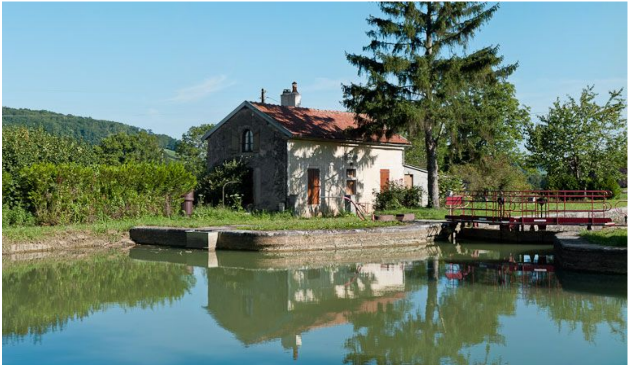
Vue du site d'écluse depuis l'amont.
