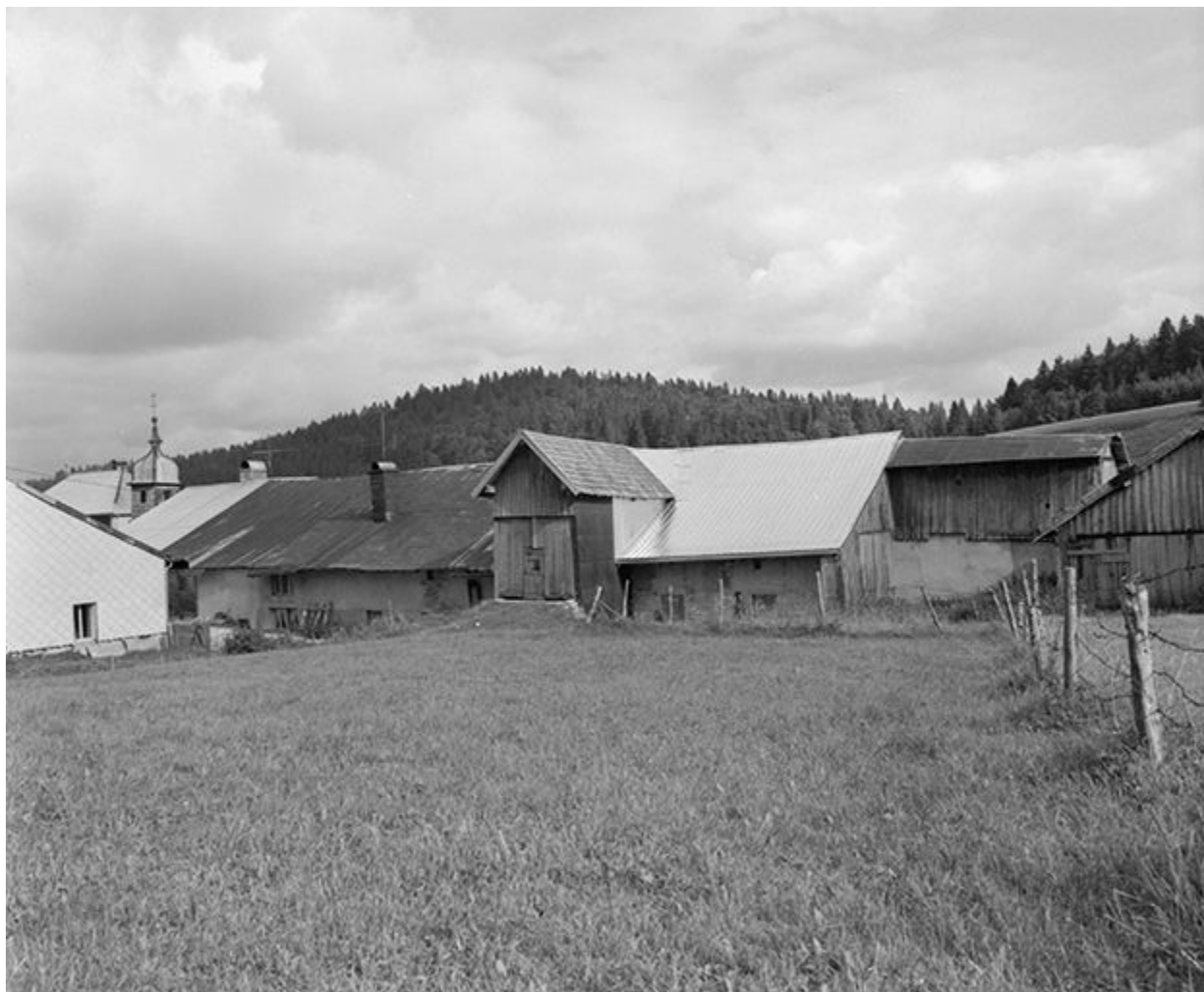
Fermes situées rue de la Fontaine : façades postérieures.
