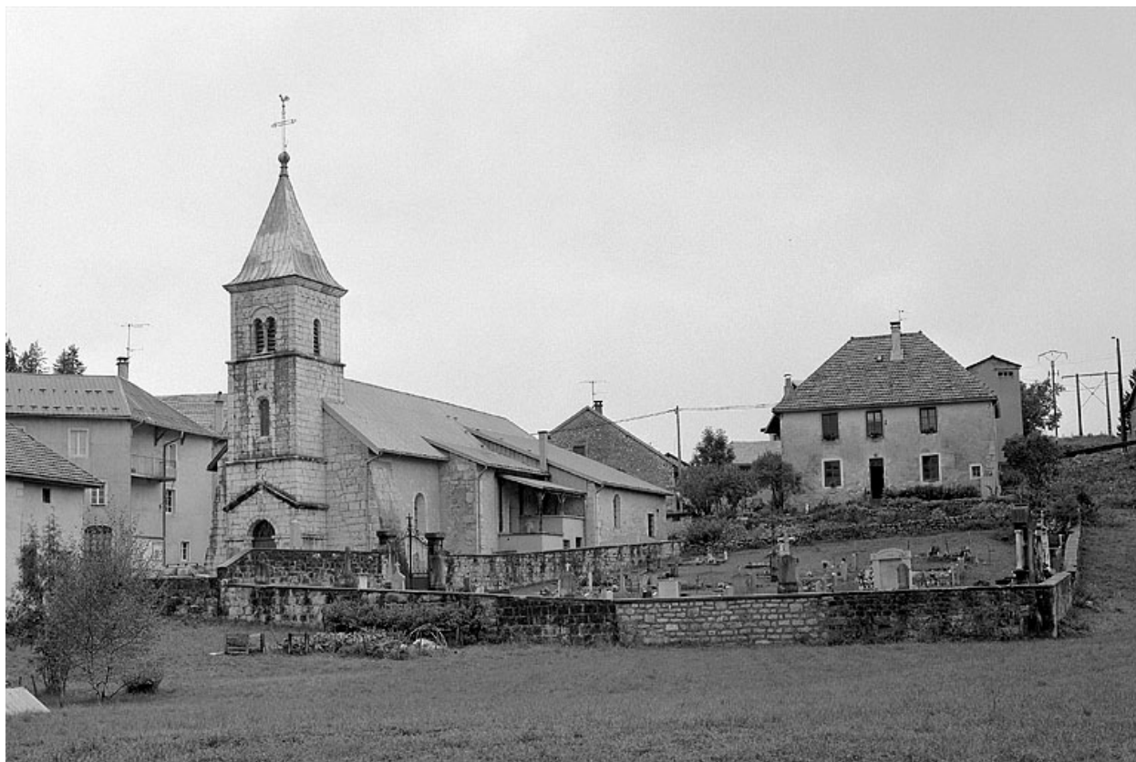
Extérieur : vue générale depuis le sud-ouest.
