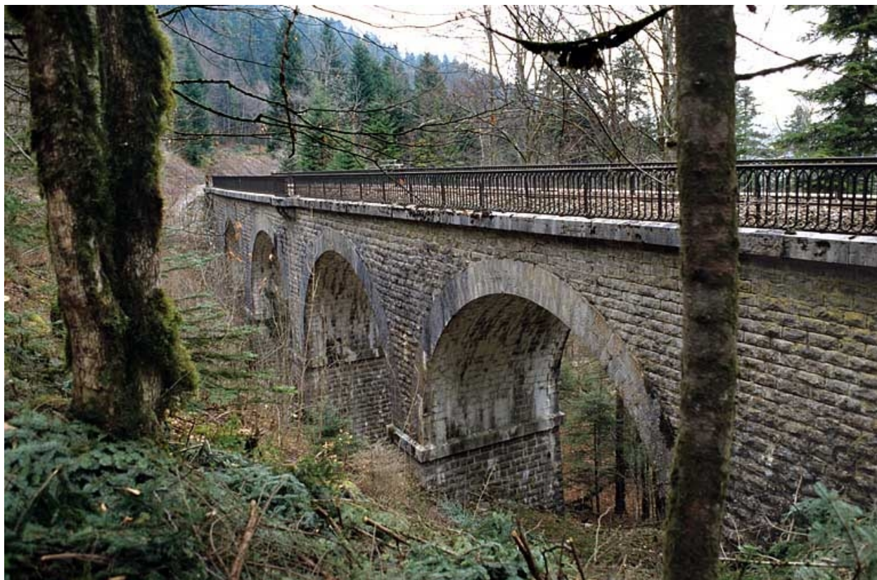
Viaduc : élévation sud (côté rocher).
